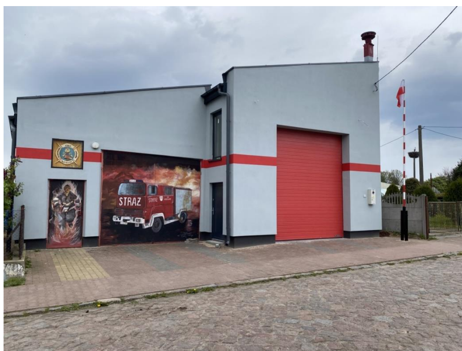
Rozbudowa i nadbudowa budynku Ochotniczej Straży Pożarnej w Kozielicach
